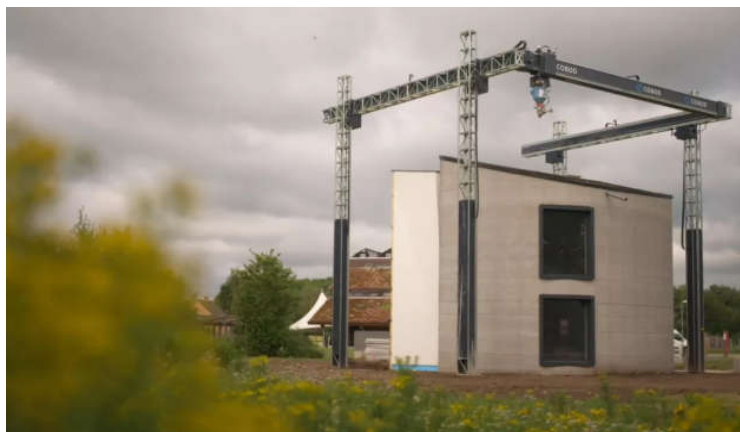
Рис. 2. 3D принтер для будівництва
