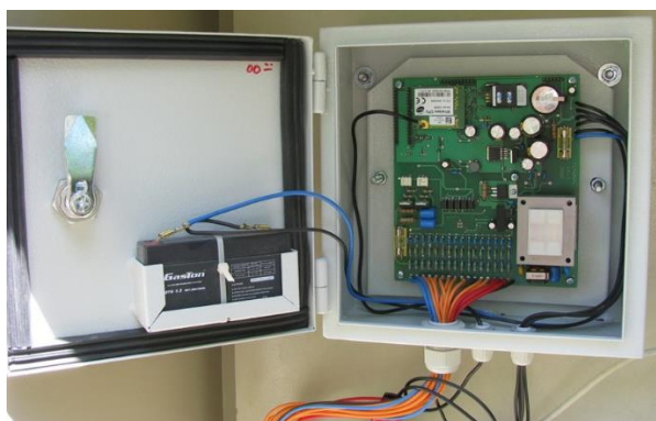
Рис. 1. Термінал управління вуличним освітленням на базі мікроконтролера типу ATmega 2560 PRO
